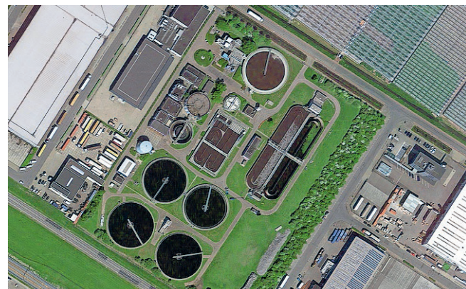
■ Bij AWZI Nieuwe Waterweg wordt de grootste collectieve zuivering van gewasbeschermingsmiddelen gerealiseerd. (FOTO: PR)
