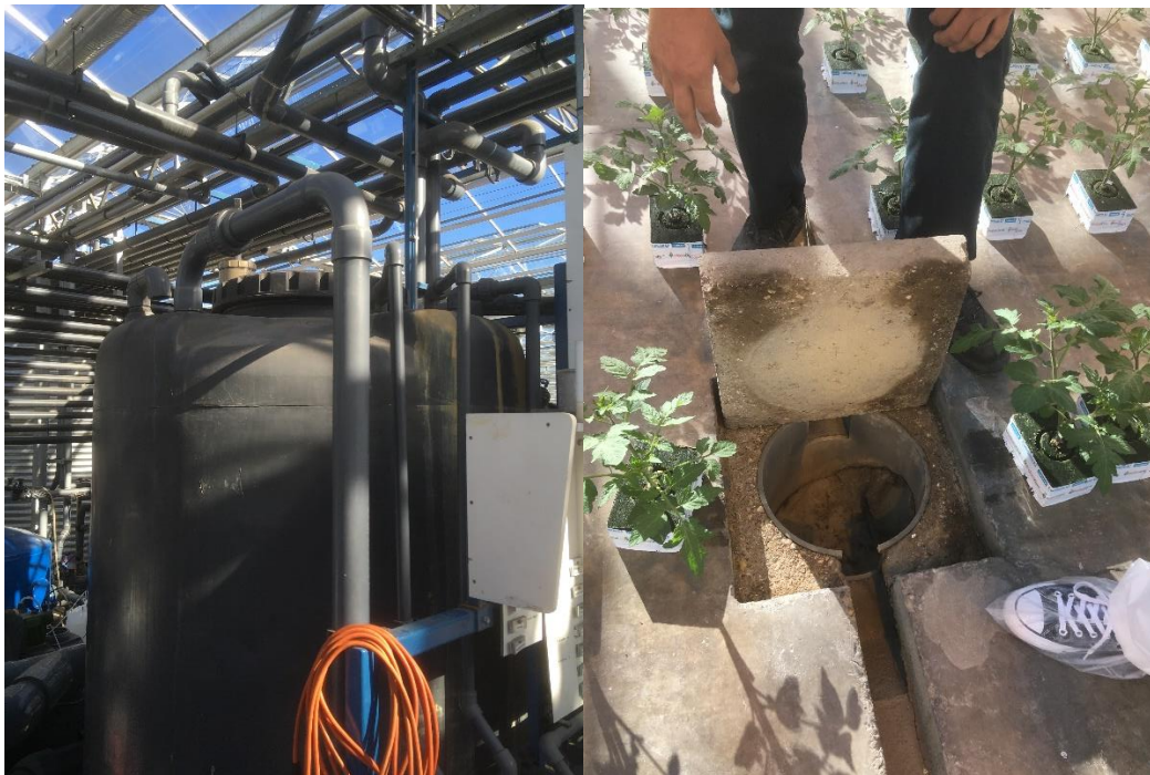
Figuur 6. Links: mengtank met mangatdeksel aan bovenzijde. Rechts: vloerput bij eb- en vloedsysteem van de afkweek. Tevens zijn hier de planten in substraatblokken te zien.
