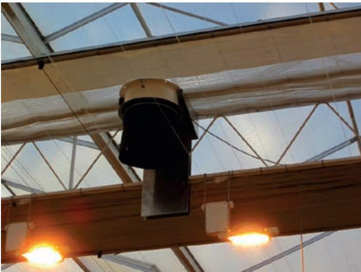
Figuur 14 Ventilator tussen de doeken met slurf van zwart doek.
