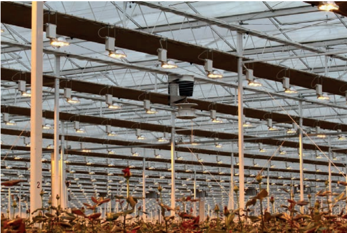
Figuur 3 VentilationJet: combinatie van VFloFan en doekventilator.
