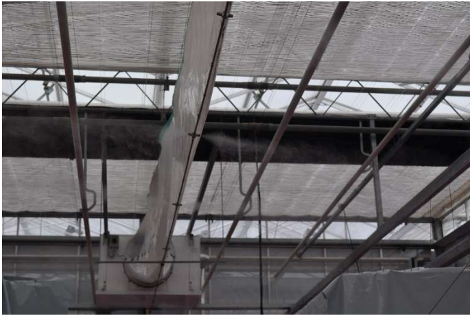
Figuur 2.2 De koelunit met uitblaasslurf, de hoge druk nevel leiding (werkend op de foto) en de schermen op 25 en 80%.
