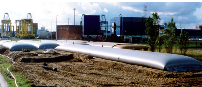
Alligator Winbags kunnen onderling worden gekoppeld waardoor er een grote en toch mobiele opslagcapaciteit ontstaat.
